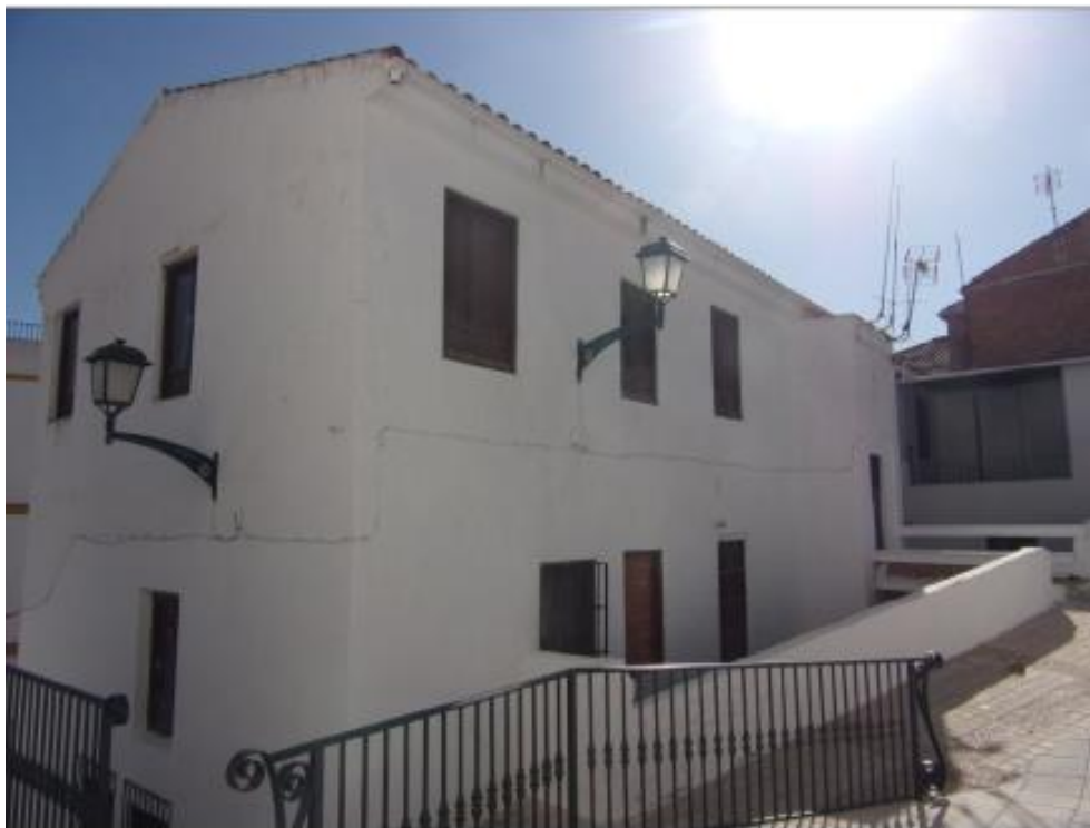
Situación actual del edificio a rehabilitar en la calle General Baena
