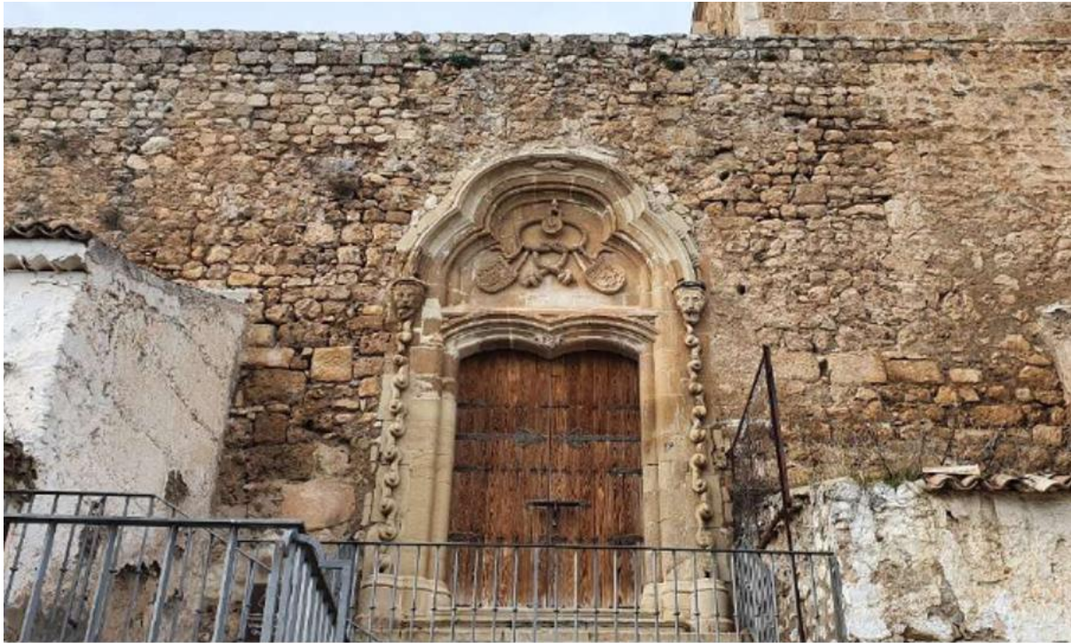
Elementos a intervenir en el Recinto Amurallado de La Guardia 3. Fuente: Ayuntamiento de La Guardia
