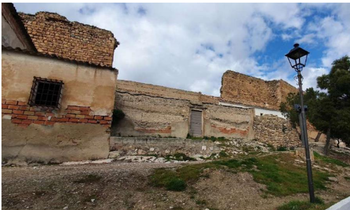
Elementos a intervenir en el Recinto Amurallado de La Guardia 2. Fuente: Ayuntamiento de La Guardia
