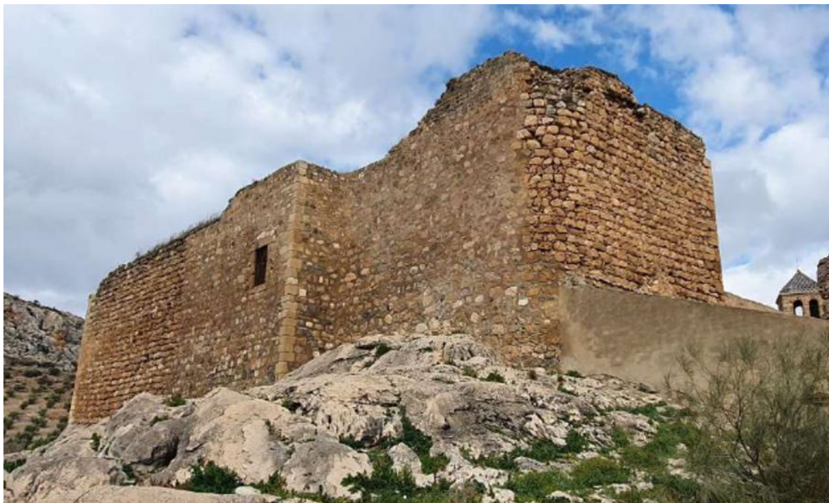
Elementos a intervenir en el Recinto Amurallado de La Guardia 1. Fuente: Ayuntamiento de La Guardia
