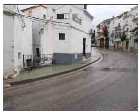
Imagen 15: Final de Tramo dirección Huesa. Edificio fuera de alineación. Curva peligrosa.
