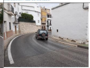
Imagen 16: Final de Tramo dirección Peal de Becerro Edificio fuera de alineación. Curva peligrosa.
